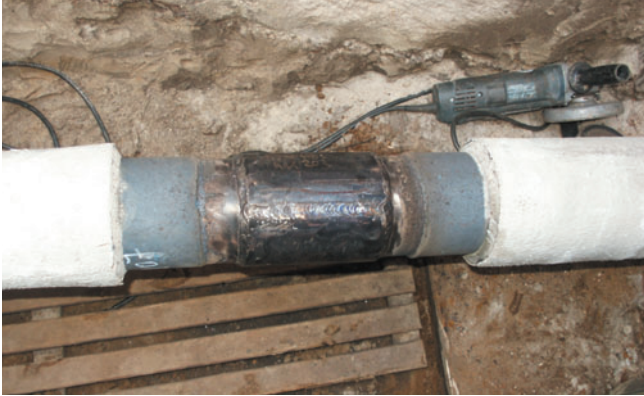
1. Rohrvorbereitung nach GW 15, sauber, trocken und fettfrei. Bei Schrumpfschläuchen-Manschetten, Vorwärmung auf 70°C
