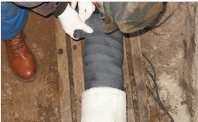
3. Wickeln des PSI Pipecast-Bandes mit mind. 1 x 75 % (4 Lagen) Überlappung nach Tränkung mit Wasser
