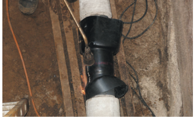
2. Montage des Schrumpfschlauches
