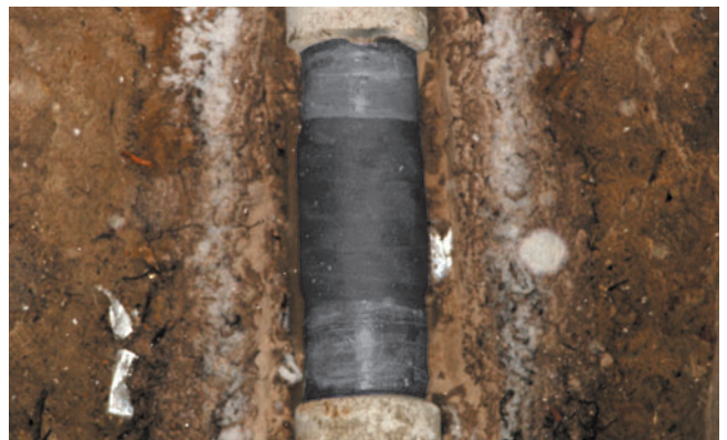
6. PSI Pipecast nach der Pressung
