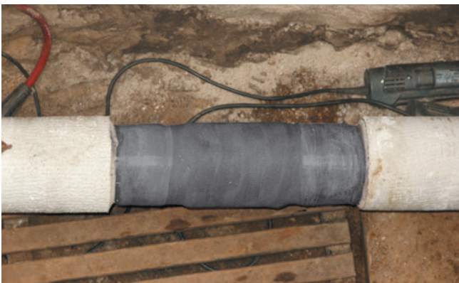
5. Aushärten des PSI Pipecast bei 23°C ca. 20-30 Minuten, einziehbereit nach ca. 1 Stunde
