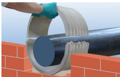
Halbschalen auf Passung zusammenfügen, bis beide Hälften auf Distanzstücke aufliegen.
