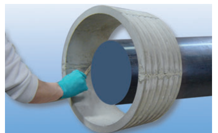
Spachtelmasse gleichmäßig verstreichen, so dass die Innenwand eine homogene Dichtfläche bildet, geg. mit Schmirgelleinen übersleifen.
